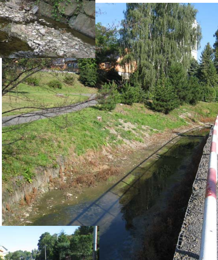
v km 4,034-4,192 – zbytky opěrné zdi budou vybourány, svah bude opevněn záhozem lomového kamene a zatravněn
