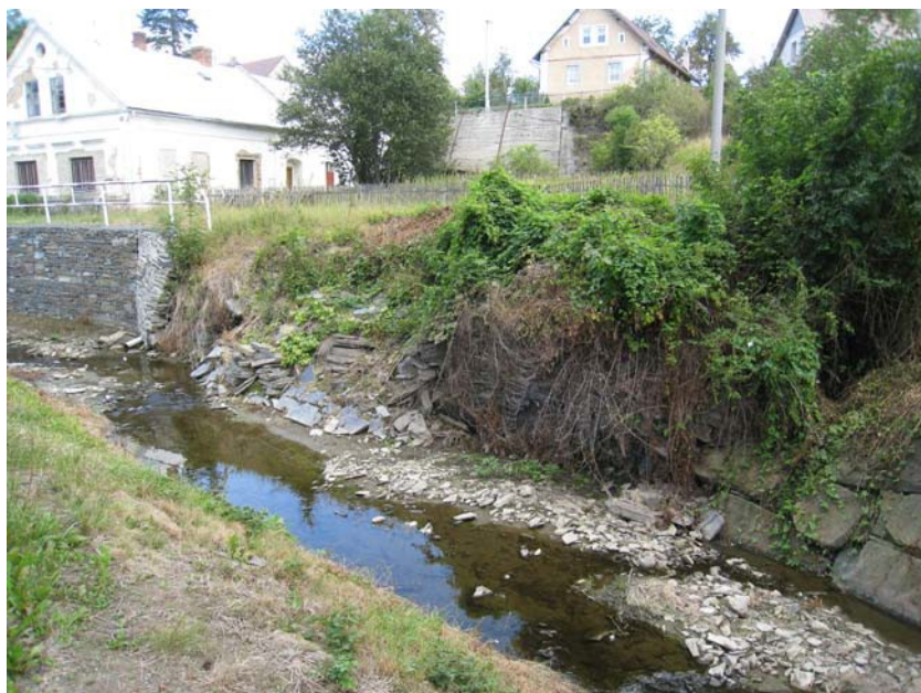
část levého břehu, kde je navrženo propojení stávajících opevnění – SO1
