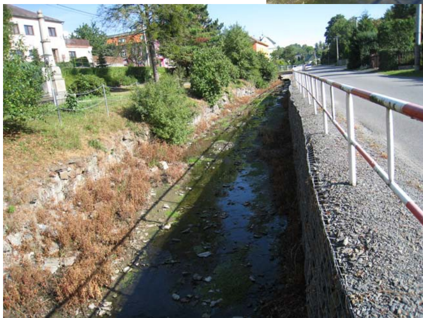
v km 4,034-4,192 – zbytky opěrné zdi budou vybourány, svah bude opevněn záhozem lomového kamene a zatravněn
